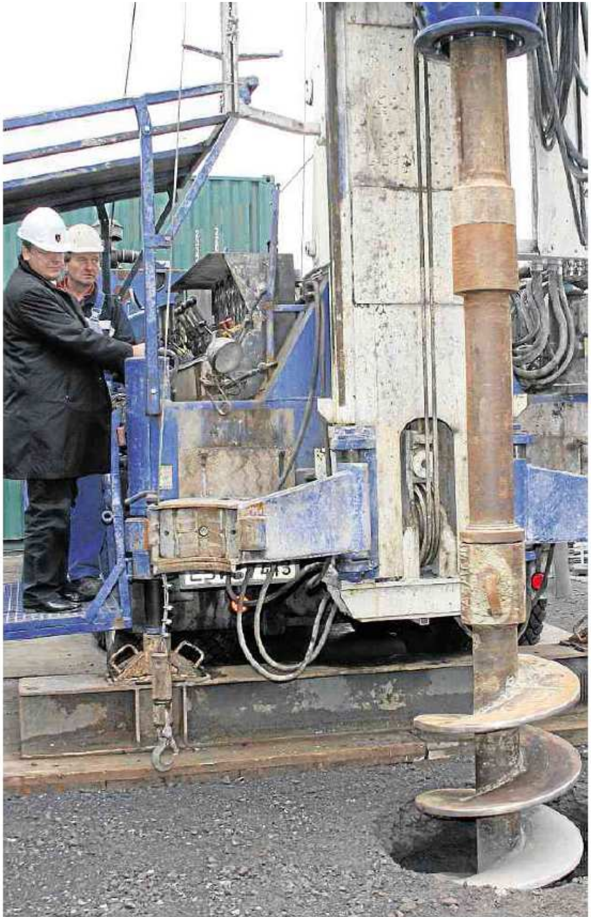
Den Startschuss zum Bohren der Thermalquelle gab Bürgermeister Walter Bersch am 14. April 2008. Foto: S. Breitbach
