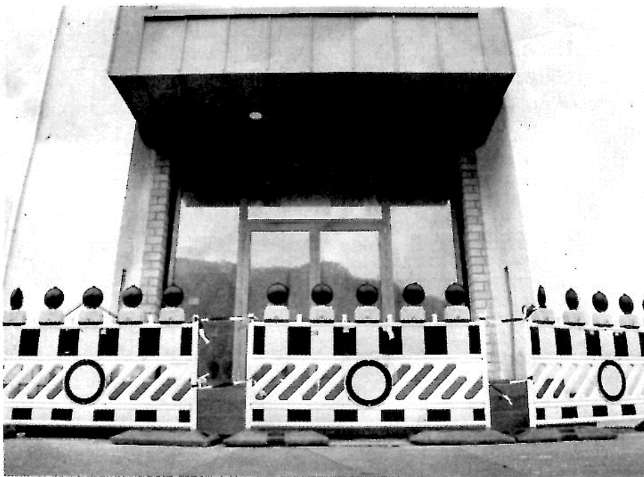
An der Baustelle „Kurfürstliche Burg“ ruhen die Arbeiten, die gegenseitigen Anschuldigungen nicht. Die Fraktionen, die kürzlich im Stadtrat den Nachtragshaushalt verhindert haben, erklären ihre Sichtweise.
